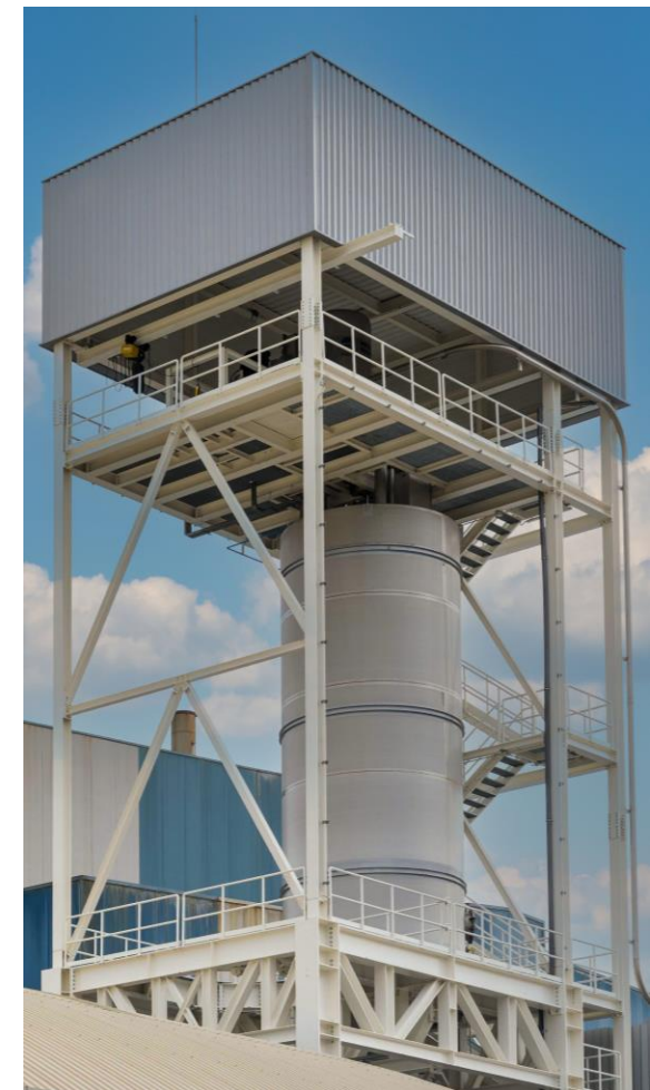
Instalaciones proyecto ZEROSILIBRINE( fase III)
